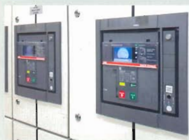
4 Воздушные автоматические выключатели серии Emax 2 в ЩСН
