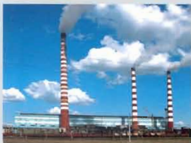
4 Общий вид Аксуской электростанции
