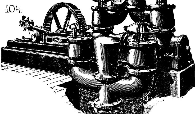
На **Фиг. 104** изображено подобное же устройство насоса *Jirard*<sup>а</sup>, выполняемое парижскимъ заводомъ *Olry & Grandemange* для большихъ расходовъ воды (отъ 18 до 250 куб. мт. въ часъ) и при высок-
