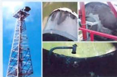
38 Фотографии антенн после попадания в них молнии
