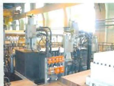
24 Узлы ЭГСРиЗ – приводы стопорных и регулирующих клапанов
