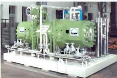
**33** Турбокомпрессор с ЭМП на станции ПХГ EWE, Nuttermoor (Германия), 5,5 МВт, 10 500 об/мин
