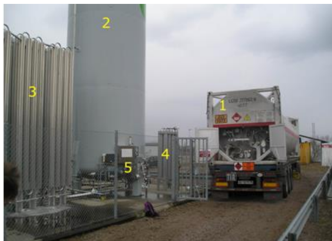
Рисунок 21. Криогенный комплекс доставки компонента, хранения, газификации и заправки СПГ:
