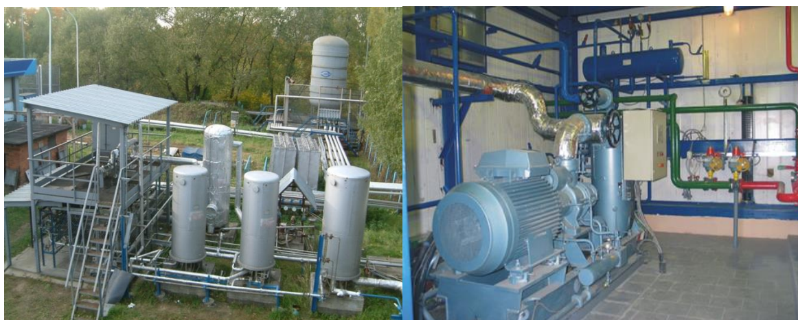
Рис.11. Общий вид криогенного оборудования (а) и компрессор ПКХМ (б) установки сжижения природного газа в п. Развилка Моск. обл.
