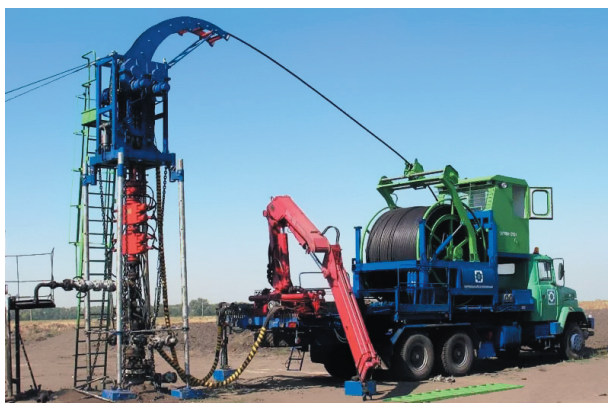
Рис. 1. Внешний вид установки механизма подачи ГТ на сборную мачту
