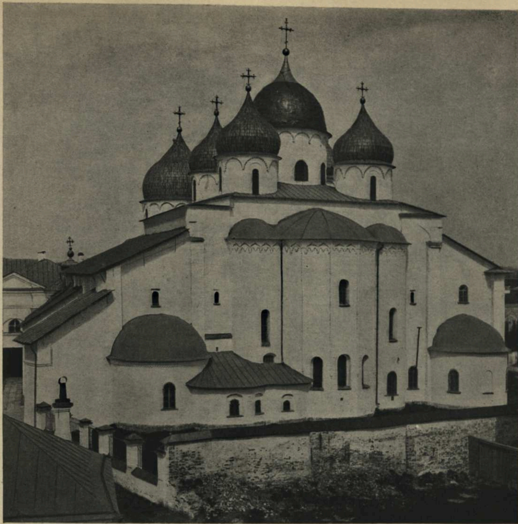
Св. Софія Новгородская. 1045 — 1052 г. Восточная сторона. (Фот. П. Ф. Борщевского, снятая до реставраціи).
