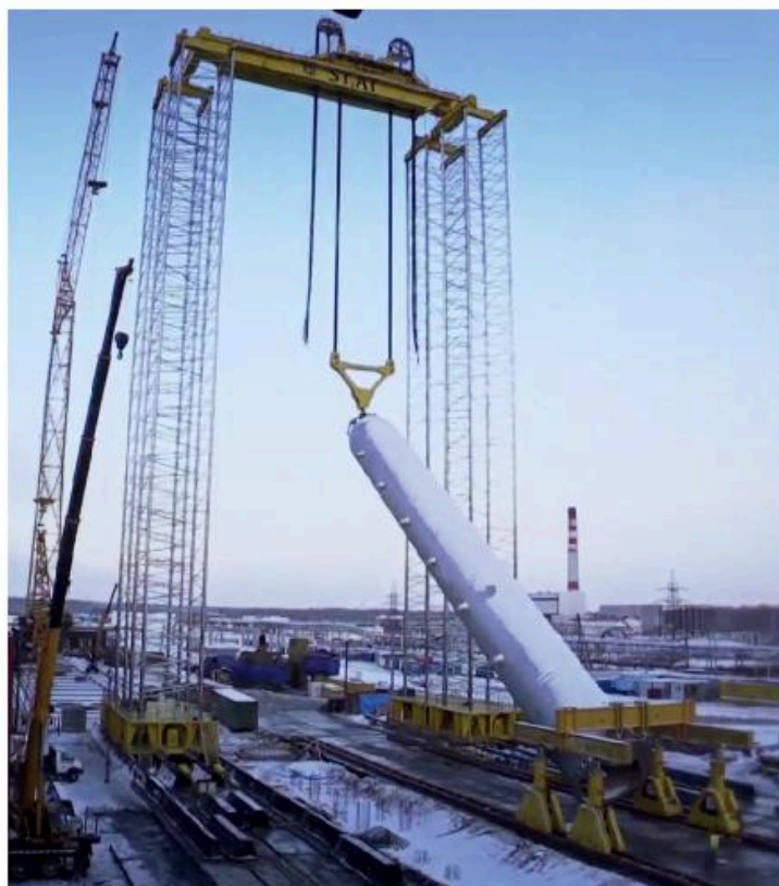
Рис. 1. Подъемно-транспортная система ENERPAC B-SET во время монтажа реакторов гидрокрекинга в Ачинске 2014
