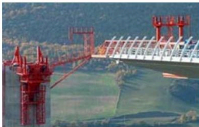
Рис. 1. Устройства временного опирания при конвейерно-тыловой сборке мостов
