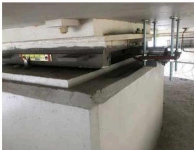
Рис. 2. Опорные узлы протяженных конструкций для реализации перемещений от нагрузок, в том числе температурных
