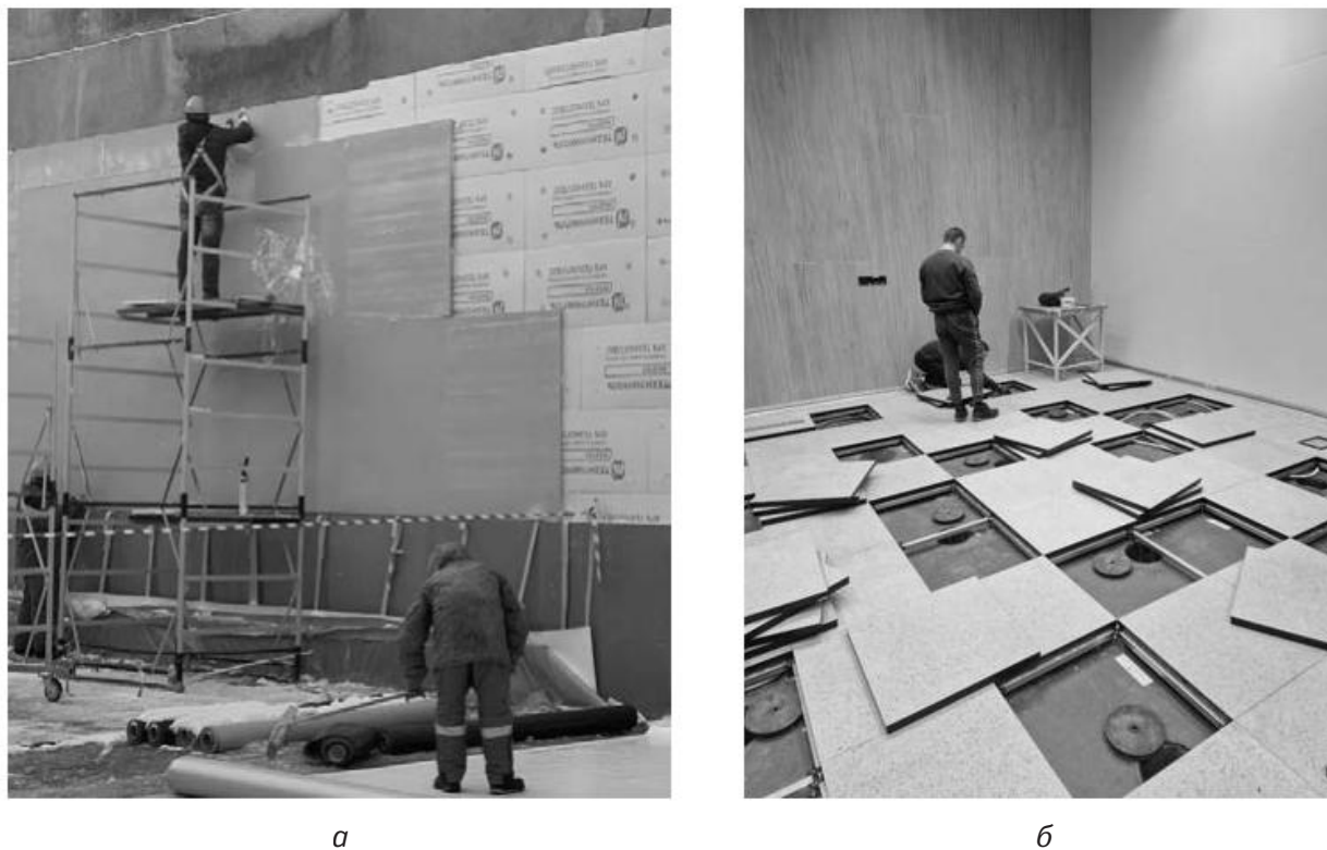
Рис. 5. Некоторые элементы каскадной системы виброизоляции:
