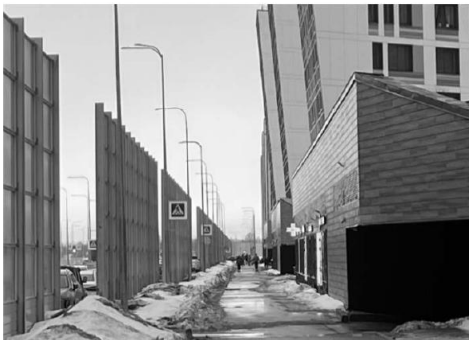
Рис. 3. Шумозащитные экраны, установленные вдоль улицы Планерная с разрывами
