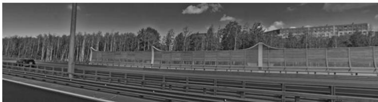
Рис. 2. Вид акустического экрана, предусмотренного для снижения шума ЗСД
