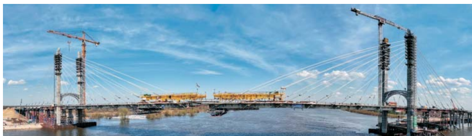
Рис. 8. Монтаж отечественной вантовой системы ООО «СТС» (мост через реку Оку)
