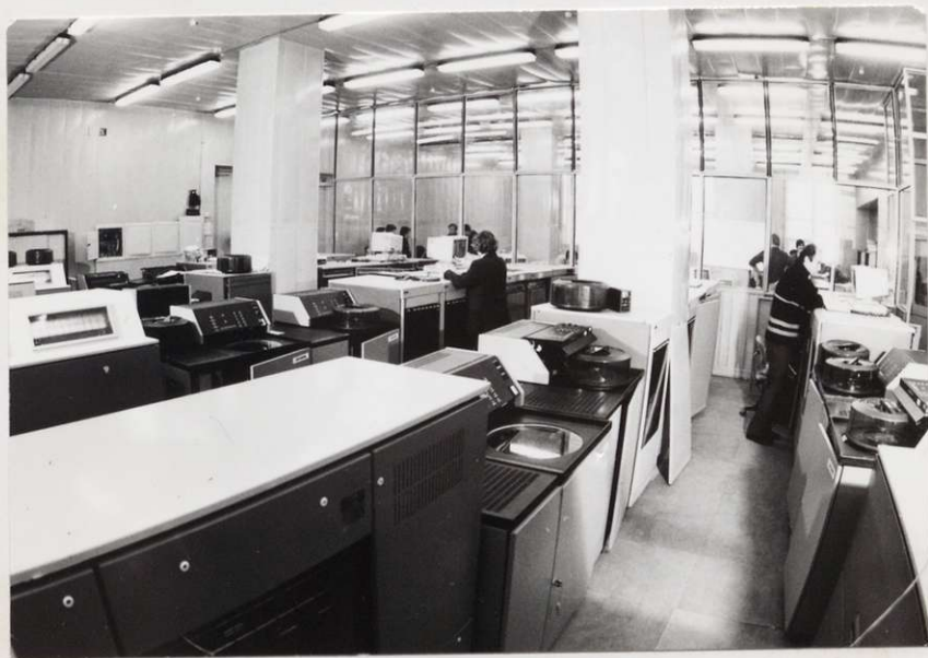
Машинный зал с комплектами "ИЗОТ - 1092С"
