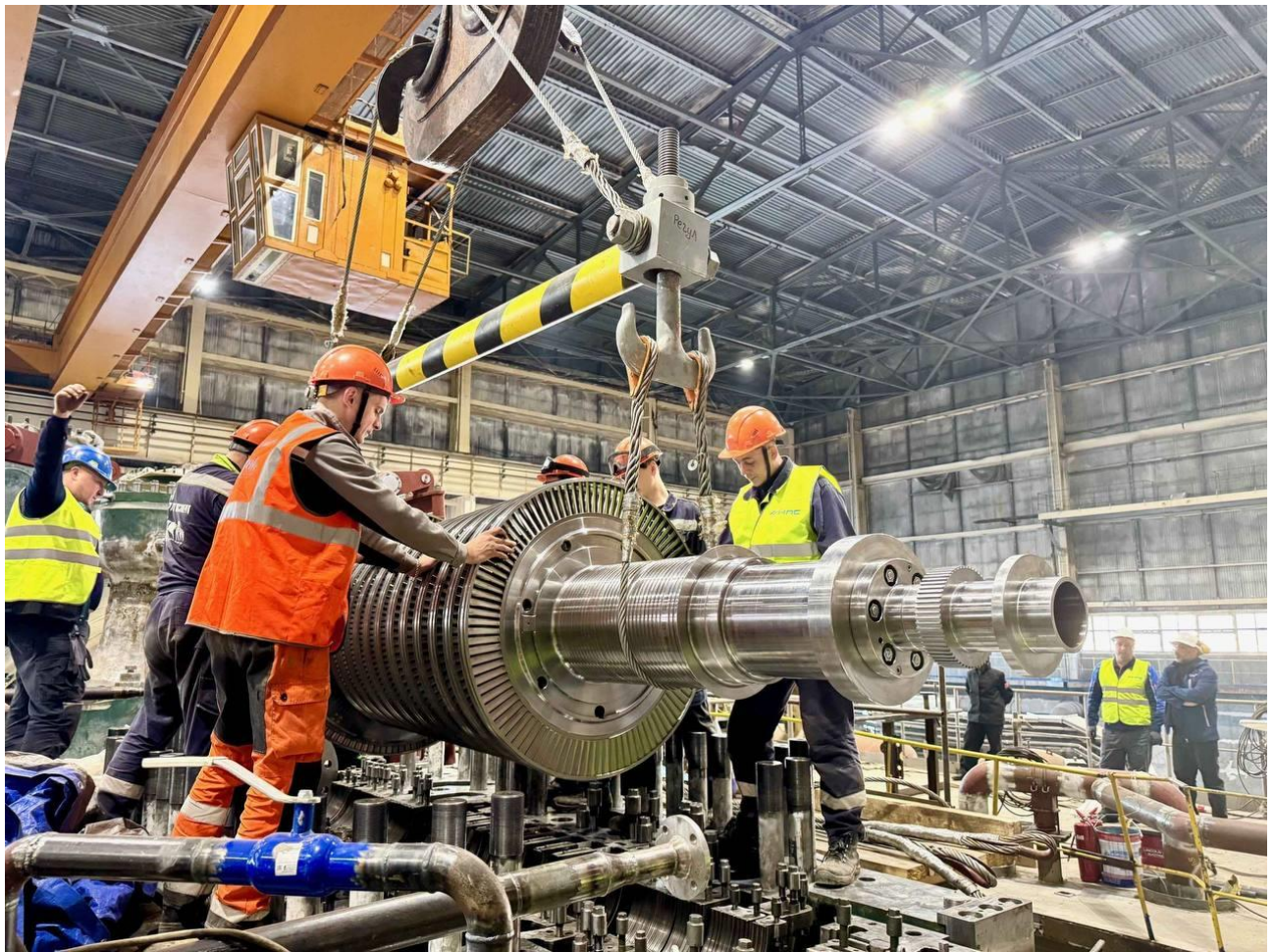
Рис. 1.2. Монтаж ротора паровой турбины Сургутской ГРЭС-1
