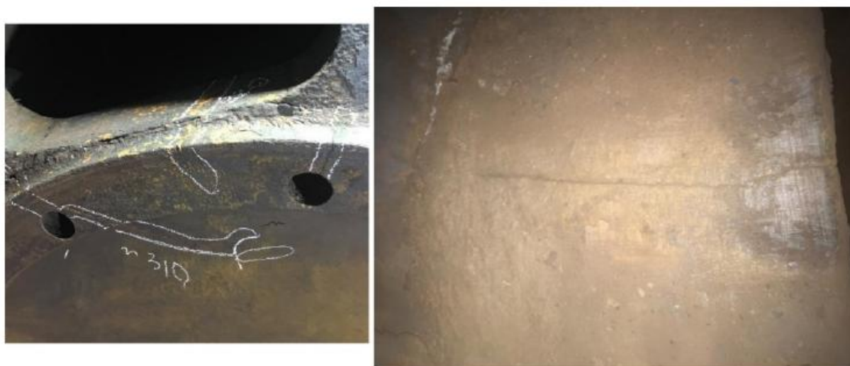
Рис. 3. Фотографии обнаруженных трещин
