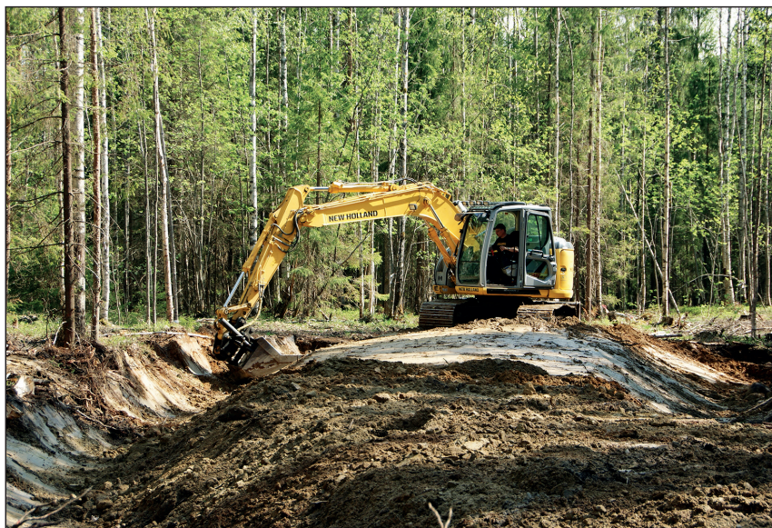
Рис. 1. Возведение земляного полотна одноковшовым экскаватором, оборудованным планировочным ковшом с режущей кромкой
