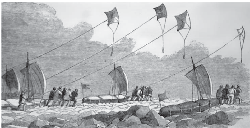
Рис. 6. Перемещение морских судов с помощью кайтов
