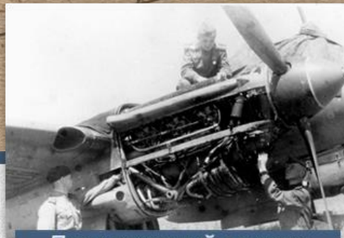
Предполетный осмотр двигателя М-105 на самолете Пе-2
