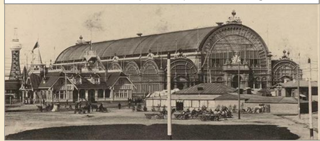
Павильон Машинного отдела с арочным покрытием системы Шухова. 1896 г.
