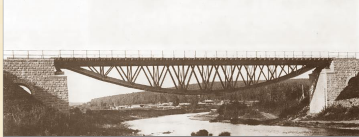
Мост через реку Ушуйку близ Томска, Транссибирская железная дорога. 1898–1899 гг.
