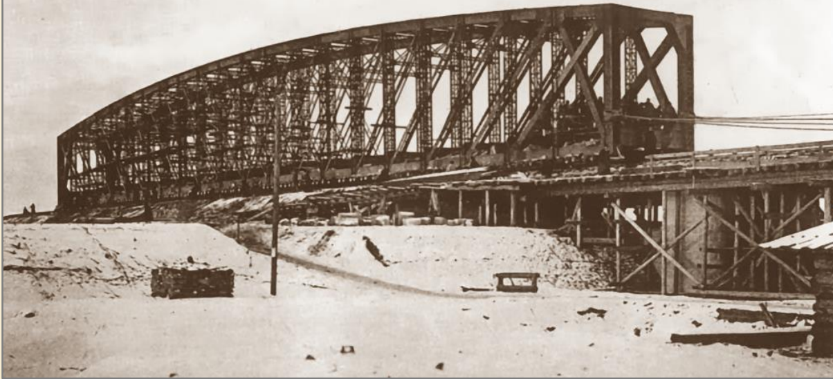
Мост через реку Оку, Транссибирская железная дорога. Здесь Шухов применил метод надвигки отдельных частей при возведении многопролётных мостов. Последнее пролётное строение затягивается в проектное положение. 21 ноября 1898 года
