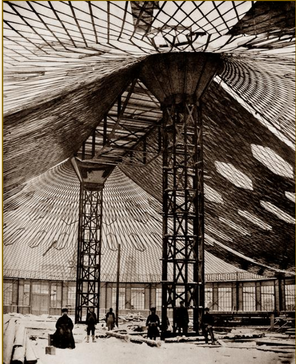
Павильон Фабрично-заводского отдела (овальный) выставки с висячим сетчатым покрытием системы Шухова на этапе строительства. 15 декабря 1895 года
