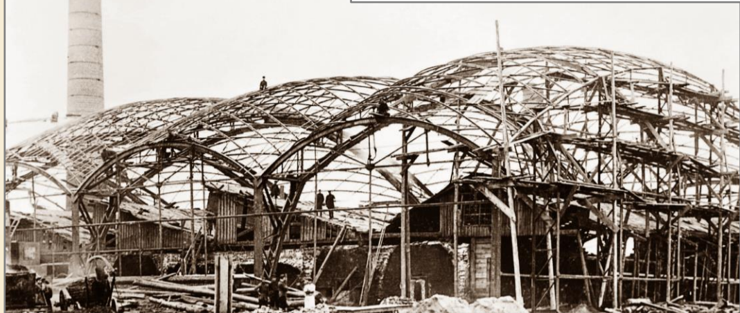
Металлургический завод в Выксе. Листопрокатный цех с сетчатым покрытием системы Шухова в процессе строительства. 1897 год
