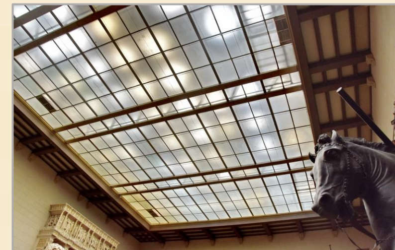
Светопрозрачная металлостеклянная крыша в музее изящных искусств им. Императора Александра III (ныне музей изобразительных искусств им. А.С. Пушкина). 1898 год
