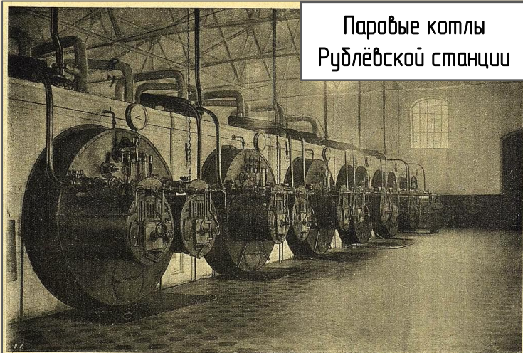
Паровые котлы Рублевской станции.
